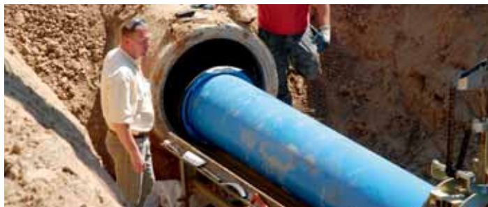
Relining dlouhých úseků
