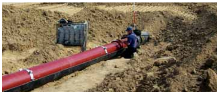
Vtlačování trub z tvárné litiny DN 400 s násuvným hrdlem BLS® do chráničky
