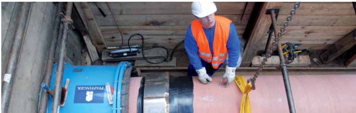
Relining dlouhých úseků
