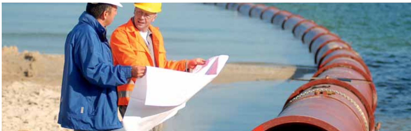
Vtahování v zatopeném kanálu: Binz/Rujána DN 1000
