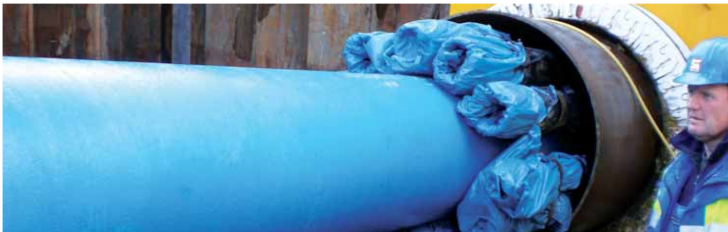
Sdružené vedení: shybka pod Rýnem ve Wormsu – DN 600
